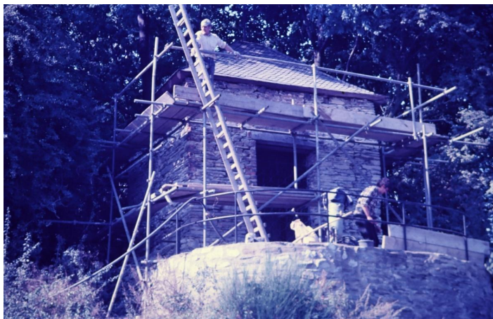
Heiligenhäuschen – Sanierungsarbeiten 1986 Foto: Johannes Herda
